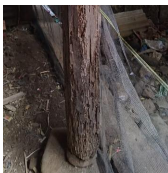
Gambar 3. Gigitan rayap berbentuk lorong-lorong
