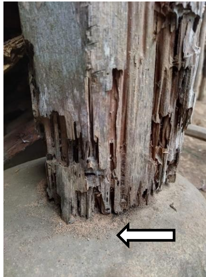
Gambar 14. Butir ekskremen bekas gigitan rayap dan berbentuk lorong-lorong
