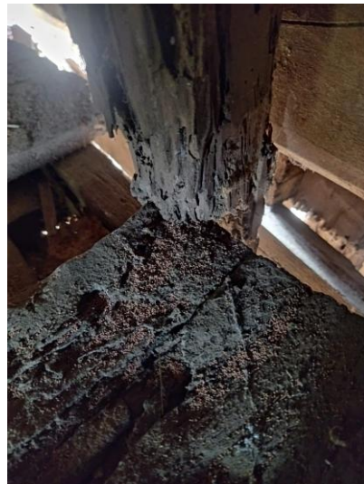
Gambar 7. Butir ekskremen bekas gigitan rayap
