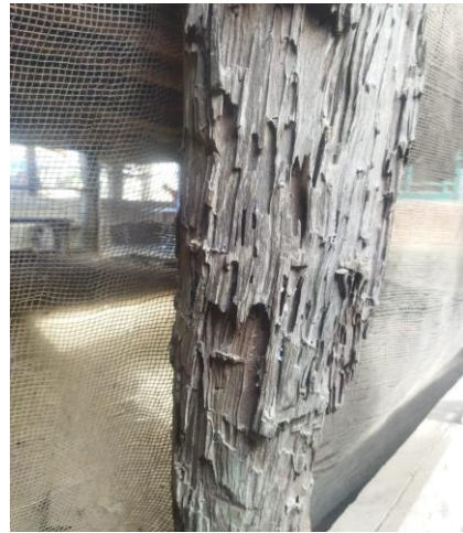
Gambar 9. Gigitan rayap berbentuk lorong-lorong
